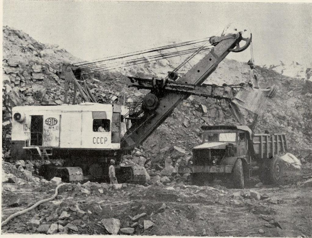
احدى الحفارات الكهربائية والسيارات القلابة التي تعمل في ازالة الصخور من موقع قناة التحويل
